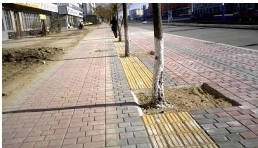
Εικόνα 13. Λωρίδα κίνησης τυφλών στο Πεκίνο, Κίνα. Ο σχεδιασμός ενδέχεται να προκαλέσει ατύχημα αφού η λωρίδα διακόπτεται από φυτεύσεις.
