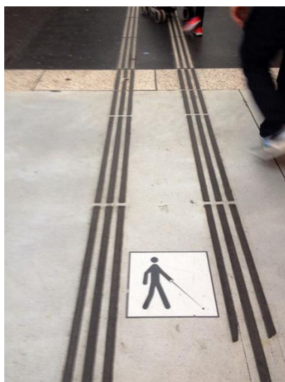
Εικόνα 12. Λωρίδα όδευσης τυφλών σε πεζοδρόμιο, επεκτεινόμενη προς το οδόστρωμα.
